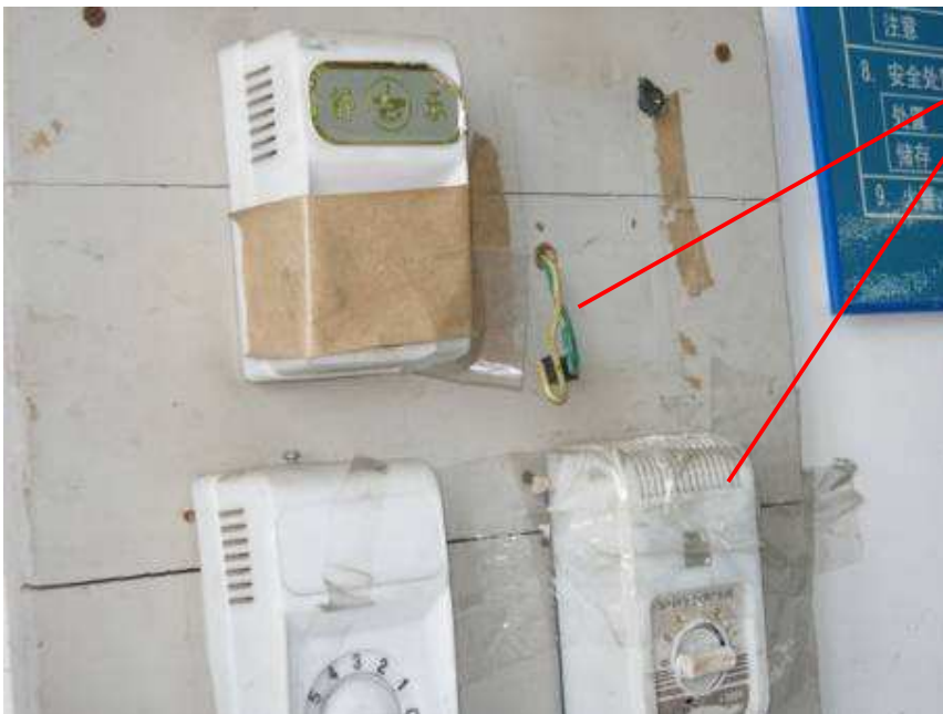
Gambar 11.14 – Buruknya Perawatan Saklar Mesin
