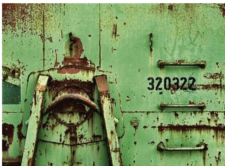
Corrosion (image courtesy of Norbert Wodhnl © Norbert Wodhnl).
